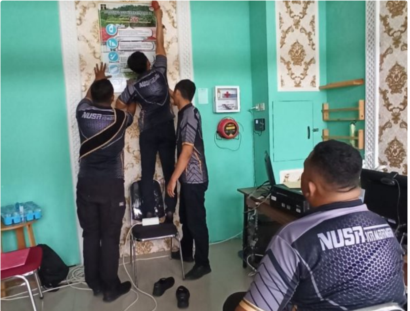
Kabapas dan Staff Renovasi Ruang Baladewa
